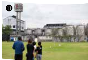
敷地内に並ぶ焼酎タンク
