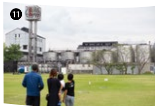
敷地内に並ぶ焼酎タンク
